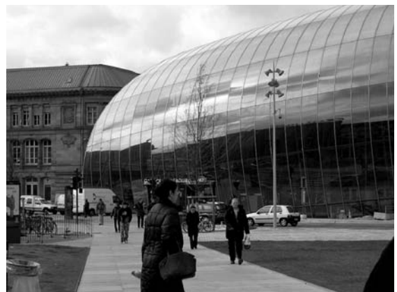
写真1：ガラスのドームでリフォームされた駅舎
