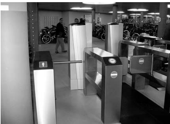
写真7：出入り口のゲートは、定期券所有者であれば、そのカードで開閉し出入りする。1日券の場合は車の駐車場と同じように入車時にカードを受け取り、退車前に自動機で料金を精算してから退車する。
