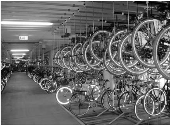
写真3：駐輪場内部は2層構造で、上層への駐輪はフックで自転車を吊り上げる方式となっている。
