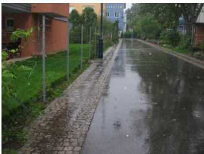
（左）道路沿いに設けられた雨水用の窪み、（中央）雨水収集の溝に雨水が溜まる様子、（右）雨水収集の溝の断面図（出展：Landkreis B.-H., Naturvertraegliche Regenwasserbewirtschaftung, 2001）
