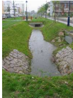
（左）道路沿いに設けられた雨水用の窪み、（中央）雨水収集の溝に雨水が溜まる様子、（右）雨水収集の溝の断面図（出展：Landkreis B.-H., Naturvertraegliche Regenwasserbewirtschaftung, 2001）
